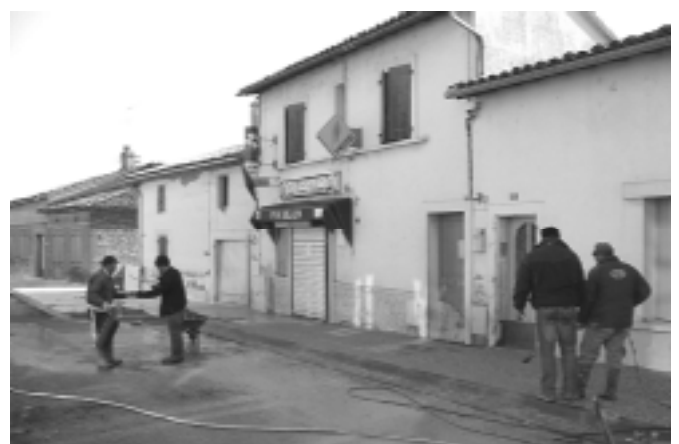
Coulage et sablage du béton désactivé
