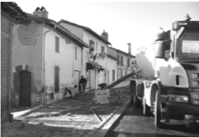
Coulage et sablage du béton désactivé
