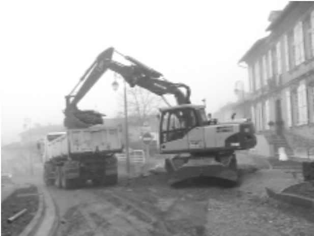
Recalibrage de la chaussée et pose des graves bitumes par l'entreprise MALET'
