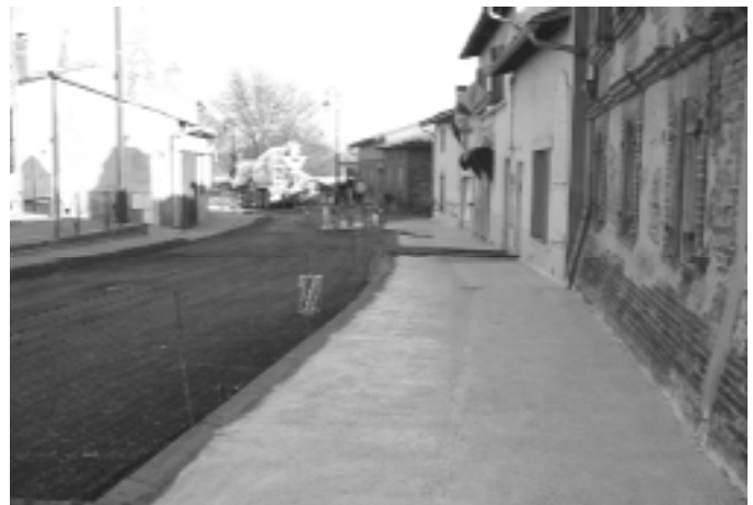
Coulage et sablage du béton désactivé
