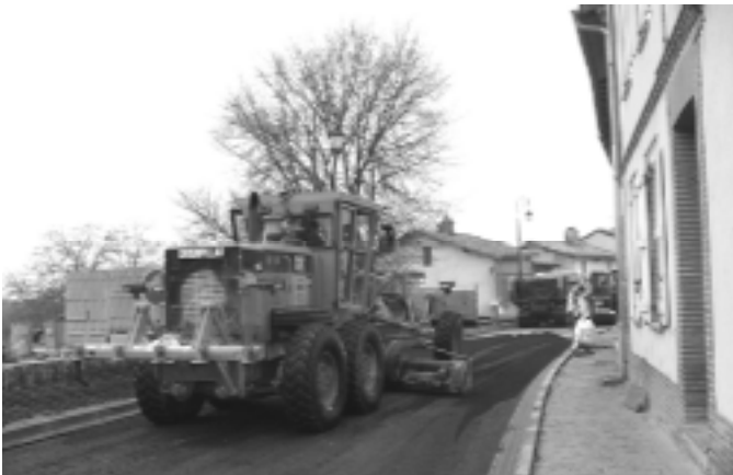
Recalibrage de la chaussée et pose des graves bitumes par l'entreprise MALET'
