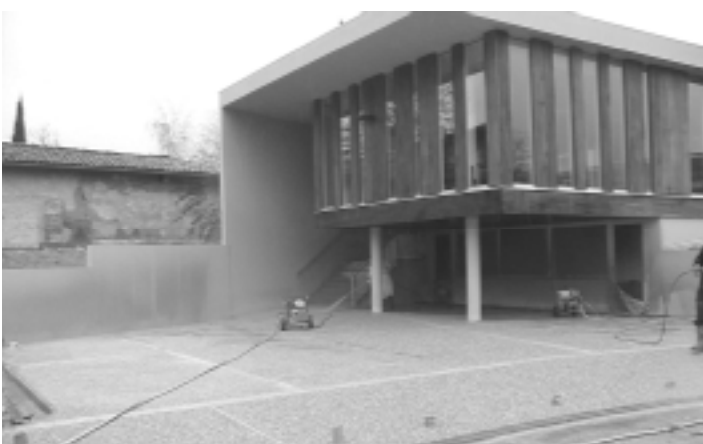
Coulage et sablage du béton désactivé
