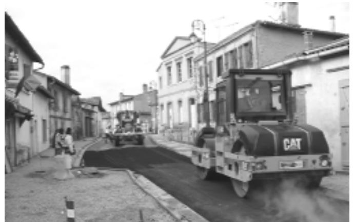
Recalibrage de la chaussée et pose des graves bitumes par l'entreprise MALET'
